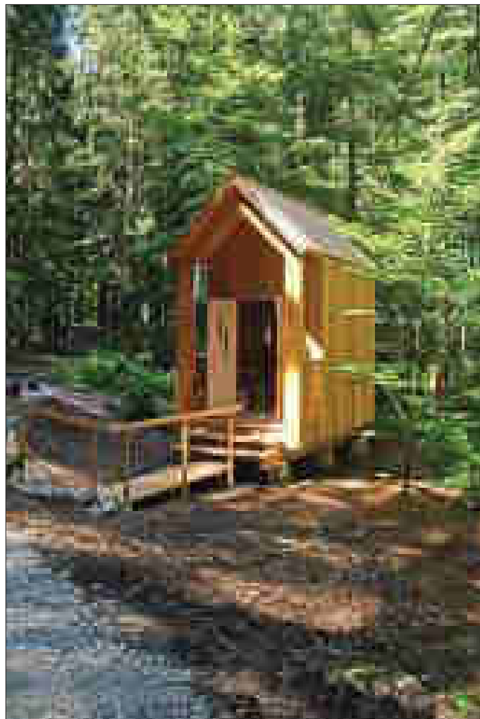
Sie ist eine Augenweide, die neue St.-Balthasar-Kapelle an ihrem idyllischen Standort im Wald bei Plosau – gebaut aus den Lärchen und Fichten, die hier bis vor wenigen Monaten noch hier gewachsen sind.
