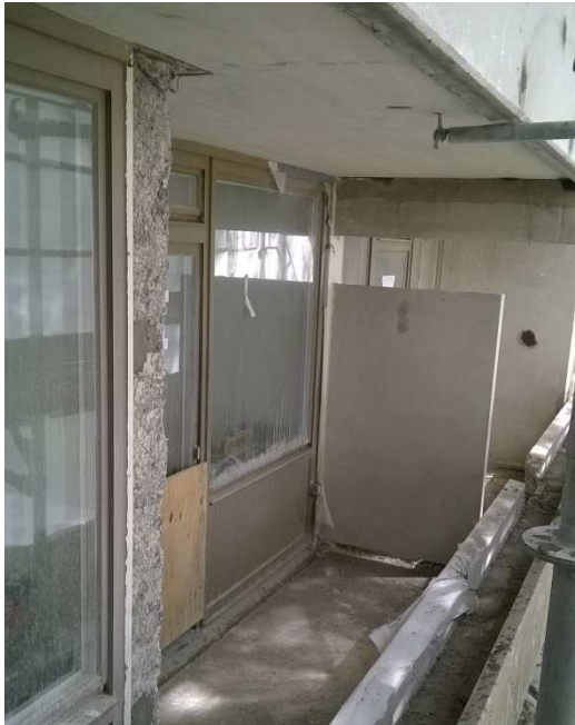
Fotos von der Baustelle: Betonsanierung
