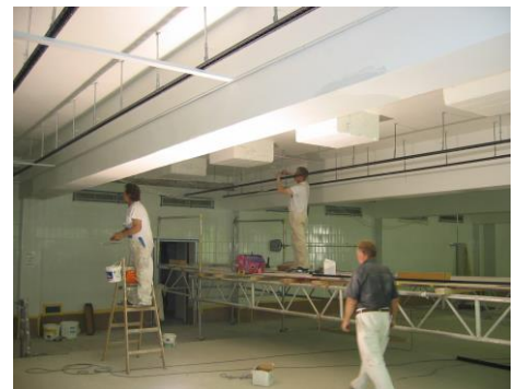
Zustand während der Bauarbeiten an der Gerhard-Hauptmann-Schule
