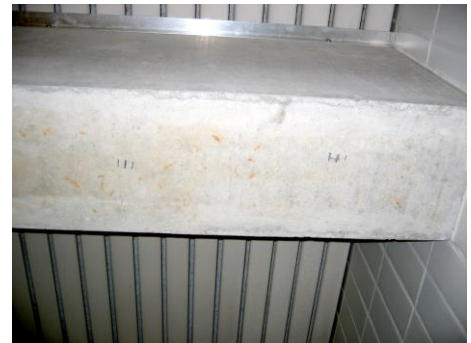
Stahlbetonunterzug (Regina-Ullmann-Schule) vor der Sanierung
