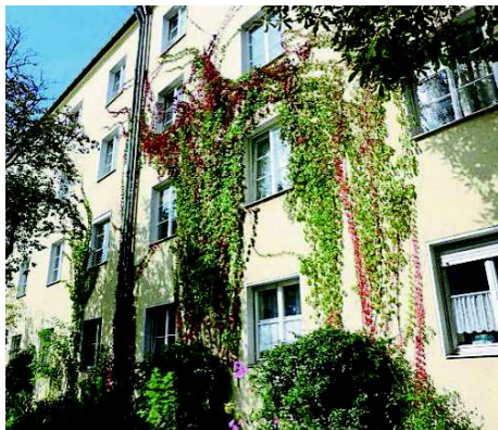
Die neuen Fenster helfen beim Strom sparen.
