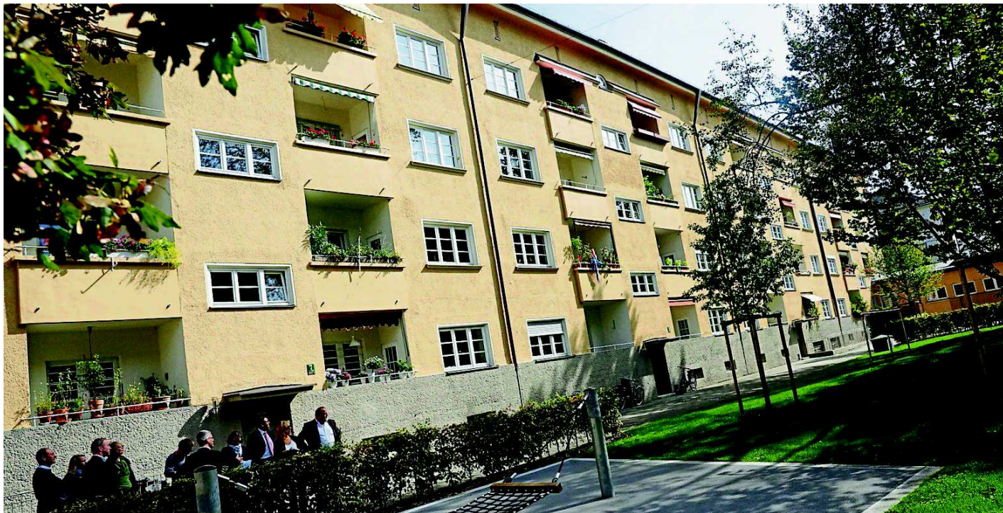
Mehr als bloß ein frischer Anstrich: Die Fassaden sind in verschiedenen dezenten Gelbtönen gehalten. Die Loggien werden von den Bewohnern liebevoll gepflegt.
