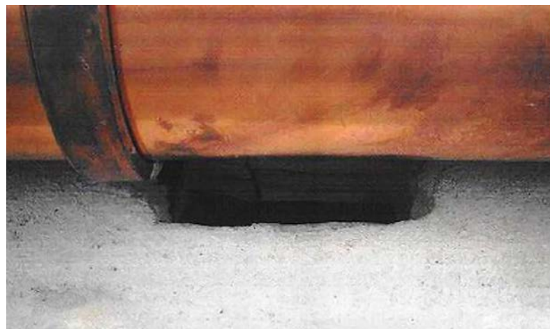
Abb. 4: Die Mauersegler-Einflugöffnung wurde im Zuge der Sanierung auf das für Mauersegler nötige Maß verkleinert.
