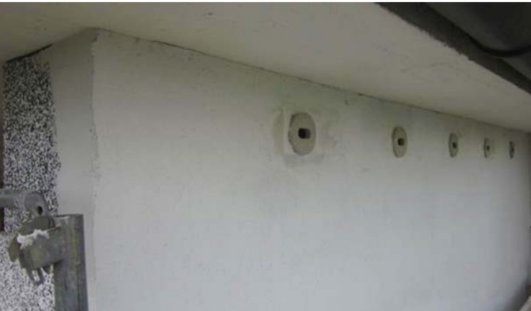
Abb. 5: Mauerseglerbrutkästen in Fassadendämmung eingebaut, vor Auftrag des Feinputzes und des Anstrichs.
